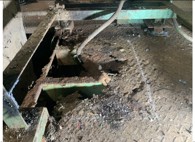
モーター台下 床も腐食が激しい為白線の部分を手直し
