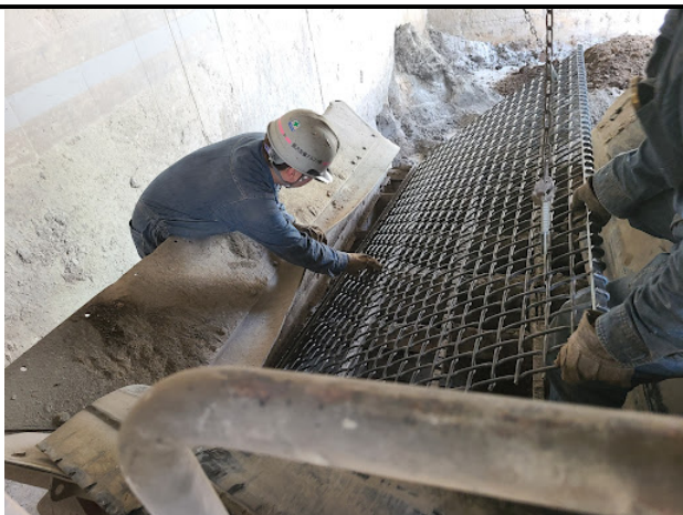
交換中2 新しい網を取り付ける
