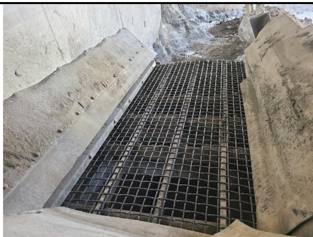
交換後 新しい網をクランピングバーで押さえ作業終了
